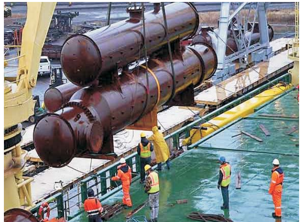
Service : Solvent Cooler Type : BKM M.O.C. : SA516 Gr60 Wt. : 76MT
